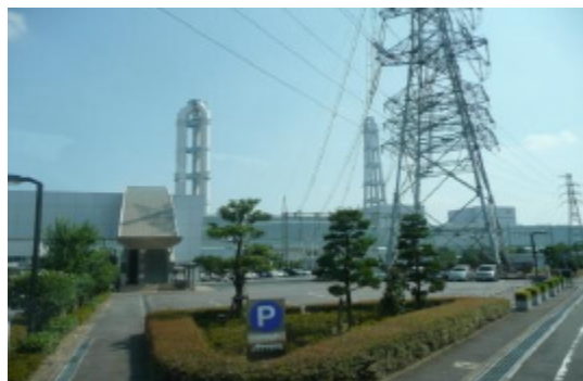
川越火力発電所
